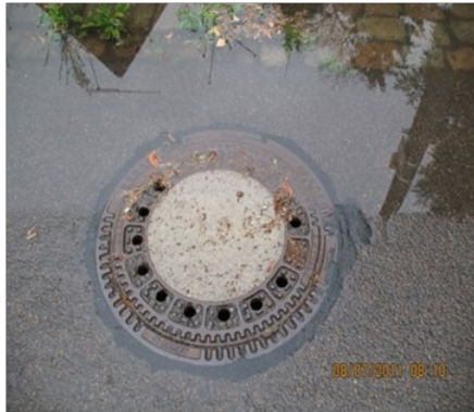
Regenwasserzufluss über Schachtabdeckungen
