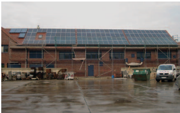
Bild 1: Anlagenerrichtung auf dem Dach der Kläranlagenverwaltung
