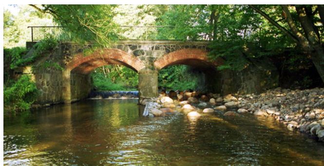
Sohlrampe Telschow - Stepenitz
