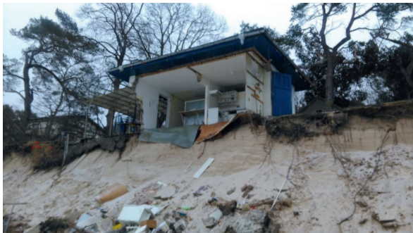
Küstenabbruch auf Usedom
