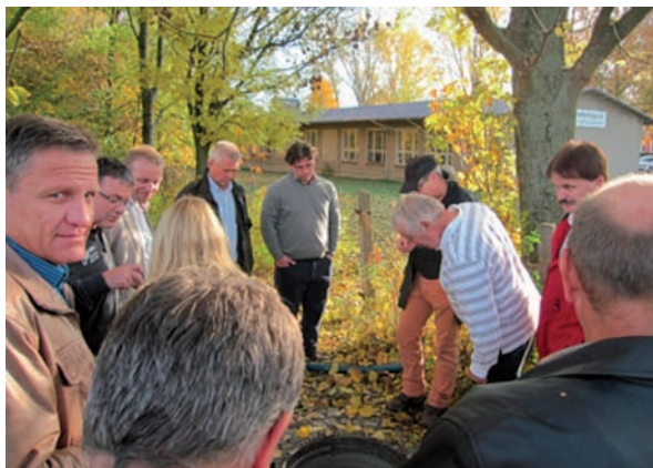
Kanalsanierungsberater Rainer Schikowski erläutert die Schachtsanierung
