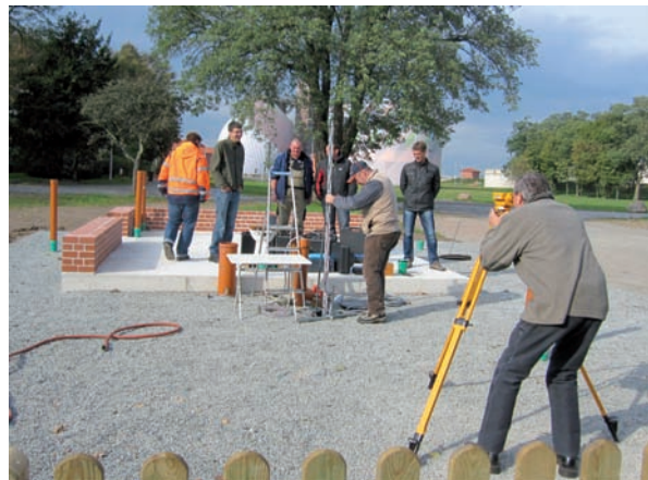
Neue Trainingsstrecken auf der Kläranlage Magdeburg-Gerwisch
