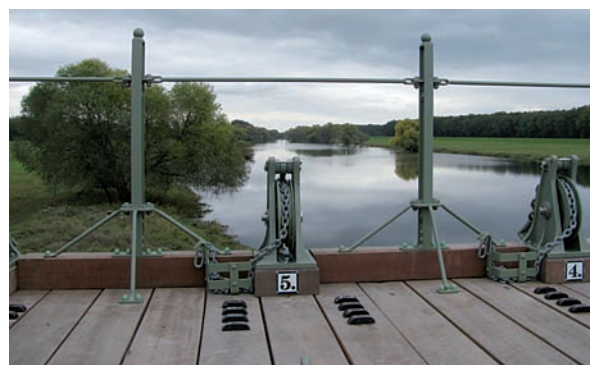
Blick vom Wehr stromaufwärts
