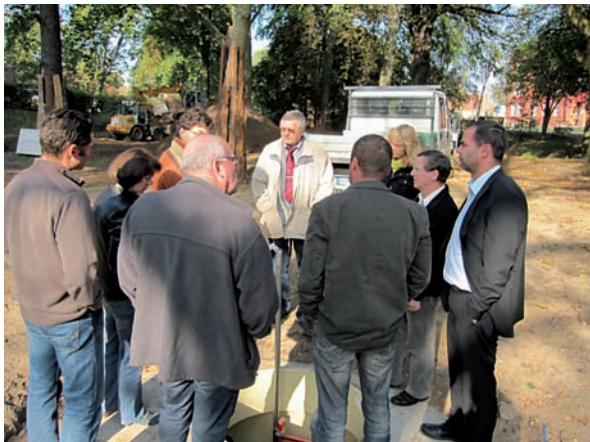
Drosselschacht am Mischwasserstauraumkanal in den Wallanlagen in Parchim
