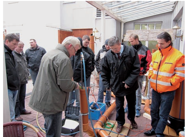
Dichtheitsprüfung an einer Grundleitung März 2010
