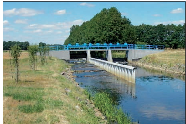
WBV Prignitz – Wehrrerneuerung mit Fischaufstiegsanlage in der Löcknitz
