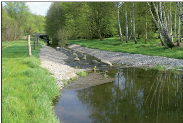
WBV Schnelle Havel – Sohlgleite im Kindelfließ
