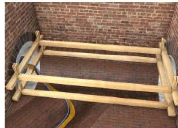
Abb. 2 Formschlüssige Ausschubsicherung mittels zimmermannmäßigem Verbau
