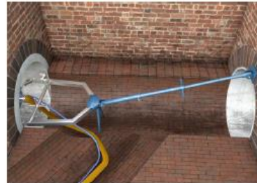
Abb. 1 Vom Herstellervorgesehene formschlüssige Ausschubsicherung
